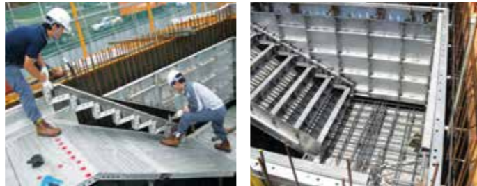
+4 Установка лестничных пролётов
