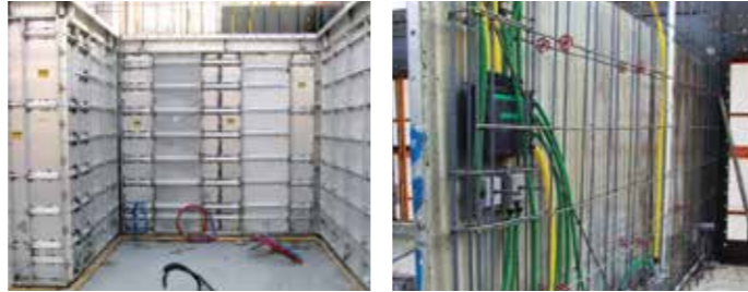
+2 Установка стеновых щитов, внутренних и наружных углов
