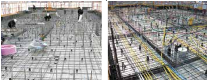
+7 Монтаж арматуры, электрических и сантехнических коммуникаций
