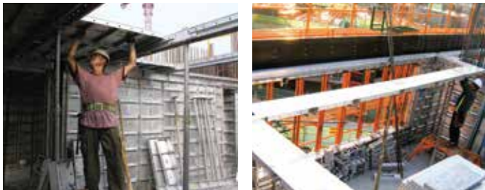
+5 Установка щитов перекрытия
